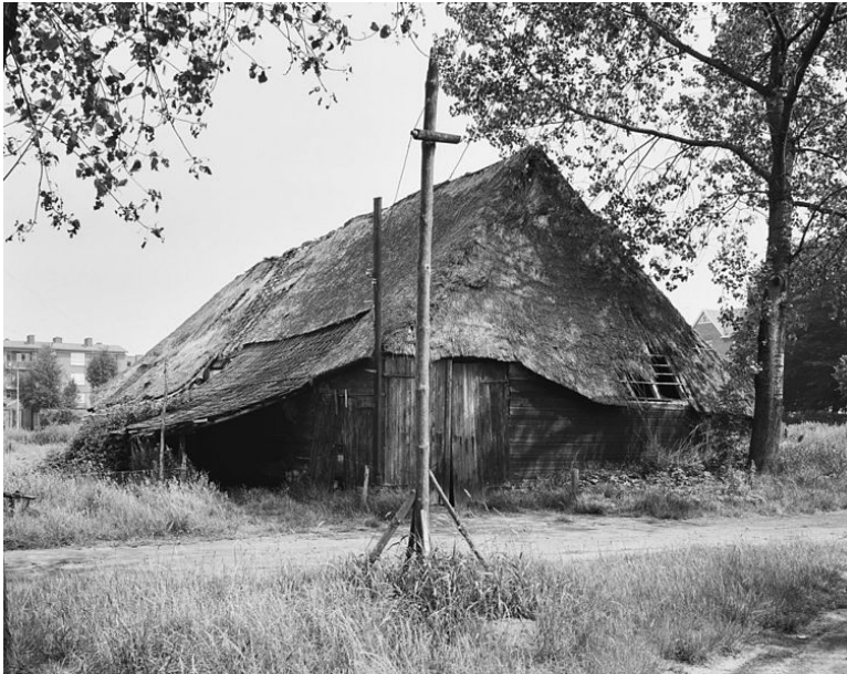
De tiendschuur of 'spijker' voor de restauratie
